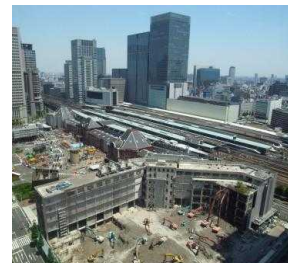
図 4. 東京中央郵便局解体風景
